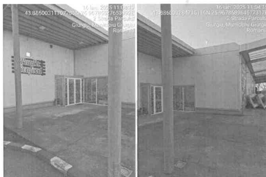
Vedere exteriora hala depozitare cu structura metalica si inchidere perimetrala perete sandwich
