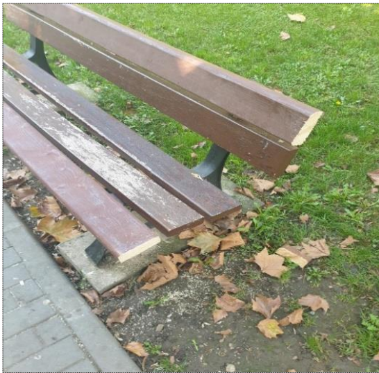
Foto 7 - Reparare mobilier stradal
