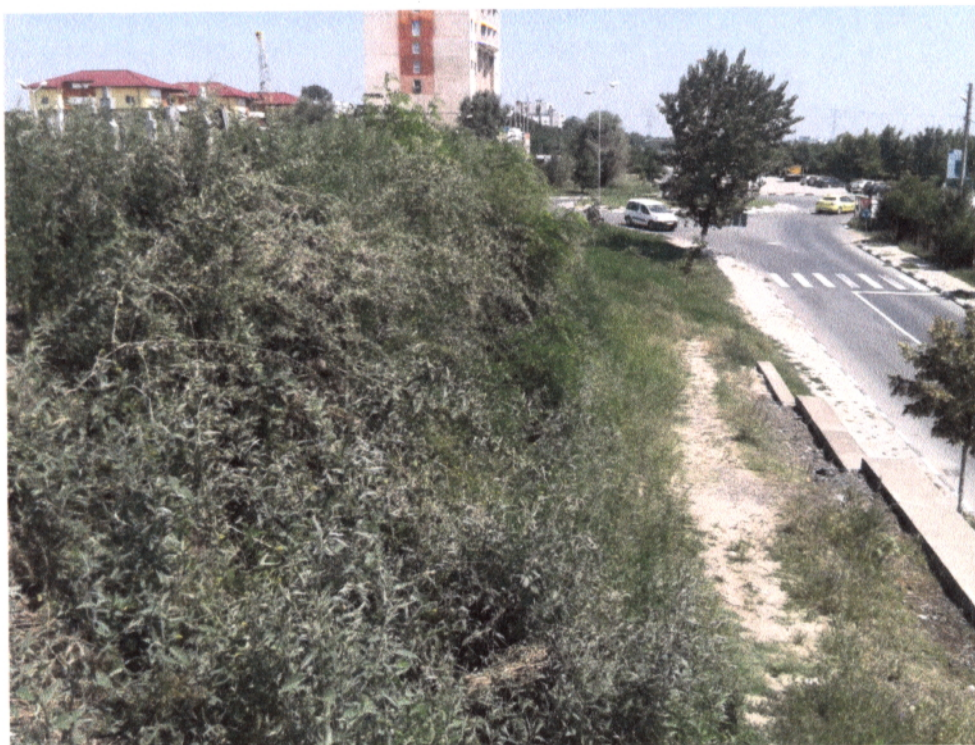
Foto 4 – Taluz Strada Unirii, capătul spre intersecția cu Bld. Mihai Viteazu – vedere de sus
