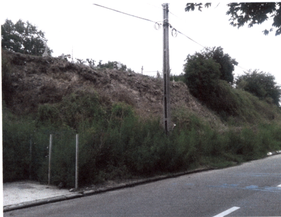
Foto 2 – Taluz Strada Unirii, capătul spre intersecția cu strada Fabricii de Zahăr – vedere de jos
