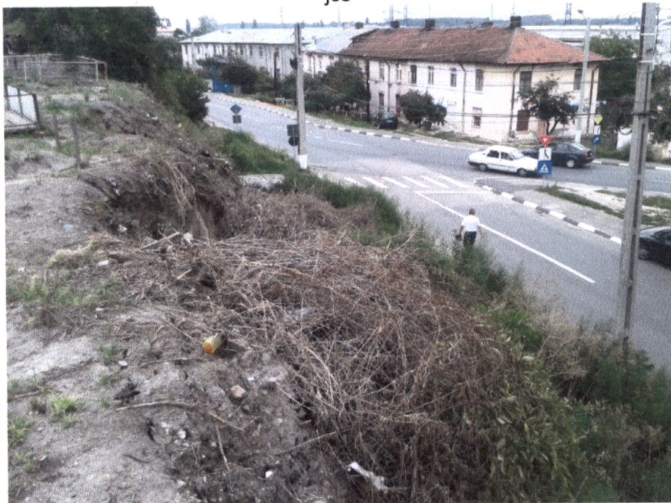
Foto 3 – Taluz Strada Unirii, capătul spre intersecția cu strada Fabricii de Zahăr – vedere de sus
