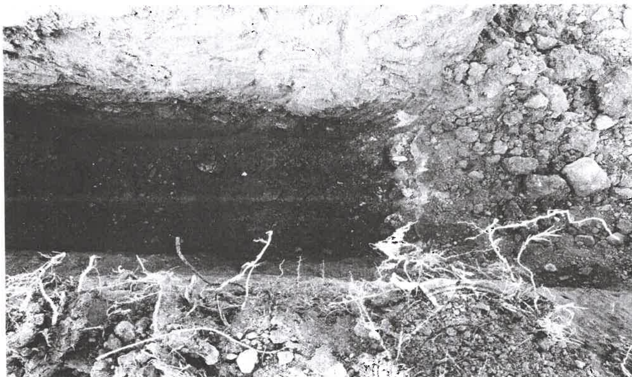
Sapatura realizata in zona exterioara a fundatiilor existente
