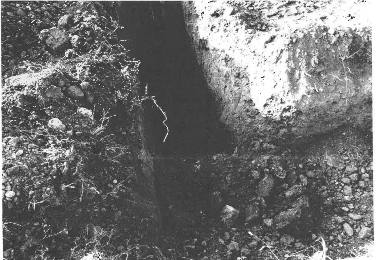
Sapatura realizata in zona exterioara a fundatiilor existente
