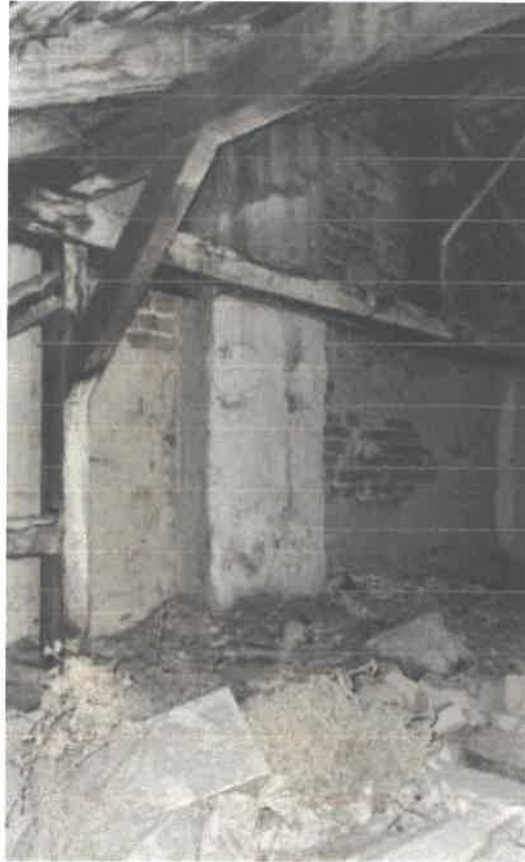
Figura 12 – Șarpanta din lemn
