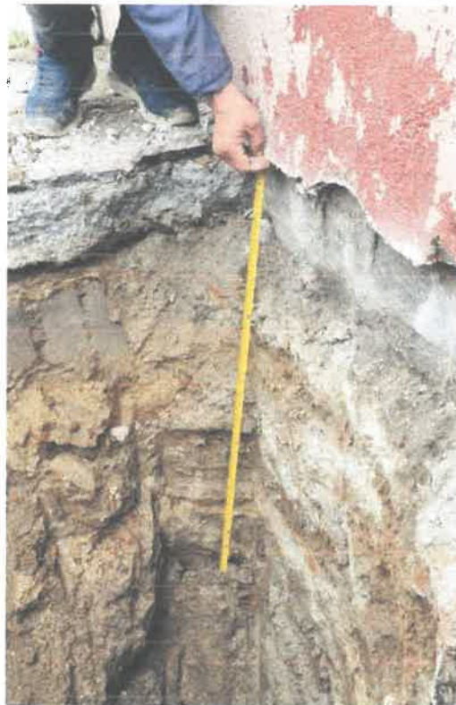
Figura 10 – Sondaj deschis la nivelul fundațiilor
