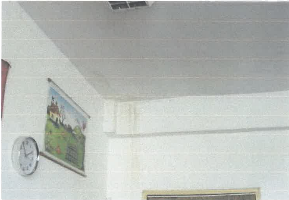
Figura 14 – Infiltrații
