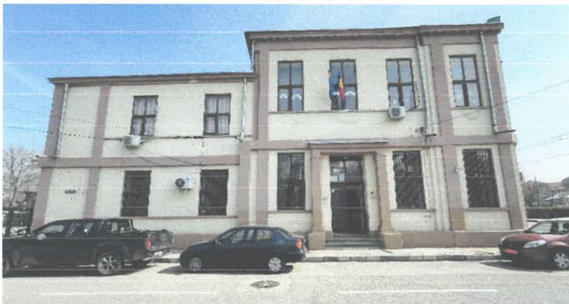
Figura 8 – Vedere Fațadă S, Corp C1
