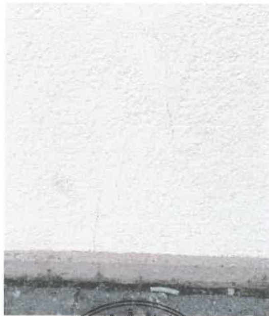
Figura 16 – Fisura în perete ce continuă și în soclu
