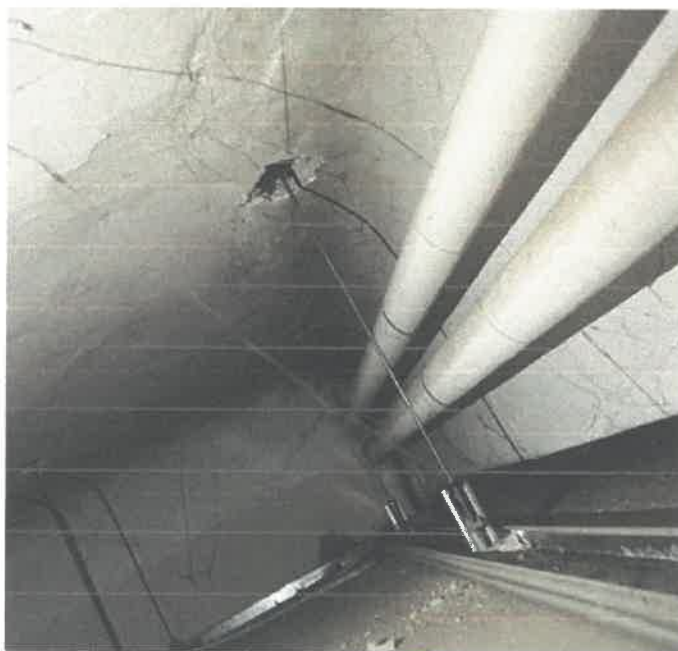
Figura 17 – Placa de beton armat
