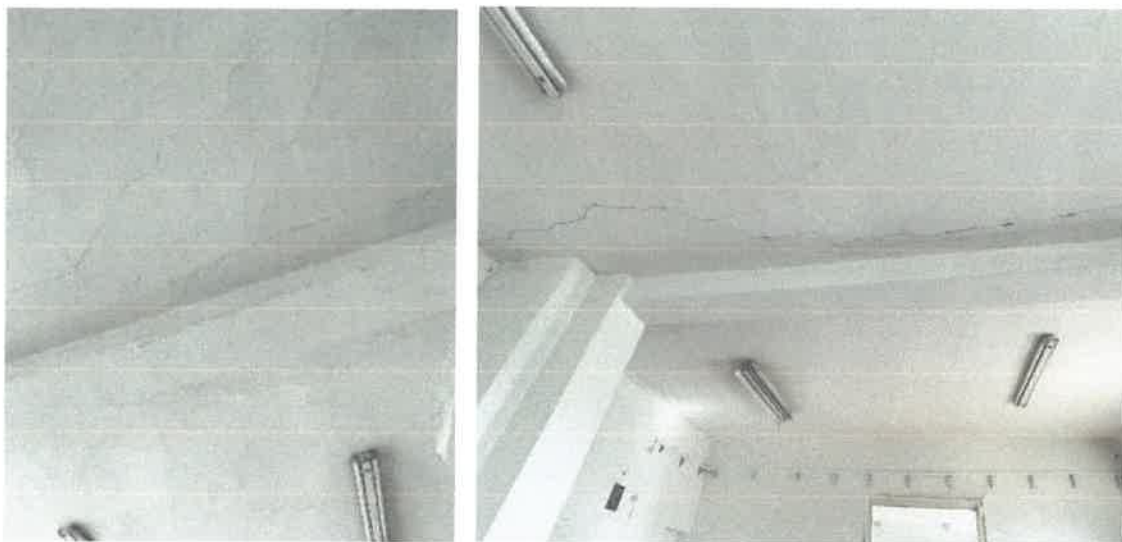
Figura 7 – Tavan fisurat
