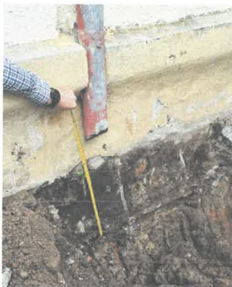
Figura 16 – Sondaj deschis la nivelul fundațiilor
