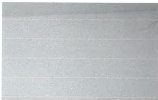
Figura 20 – Fisuri in pereți și tavan
