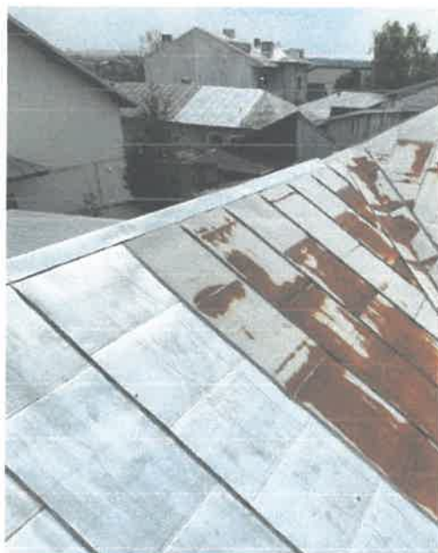
Figura 18 – Învelitoare peste șarpanta din lemn
