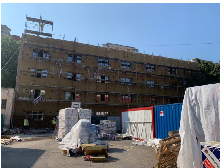
Foto 20 – imagini din timpul execuției lucrărilor la internatul Colegiului Ion Maiorescu
