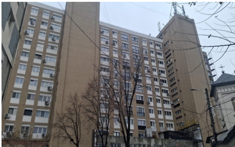
Foto 18 -19 – Imagini din timpul execuției lucrărilor
