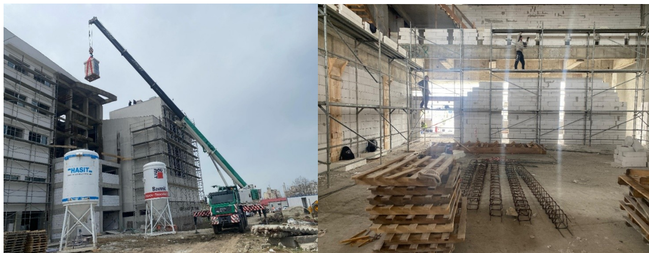
Foto3 - 4 - Imagini din timpul execuției lucrărilor la Casa Tineretului
