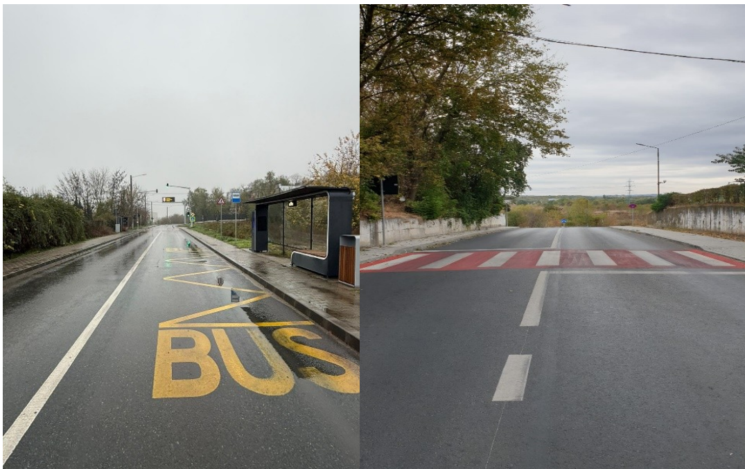
Foto 5 – 6 - imagini de pe străzile reabilitate/modernizate
