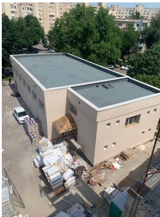
Foto 21 – Sala de Sport a Colegiului Ion Maiorescu, reabilitată.
