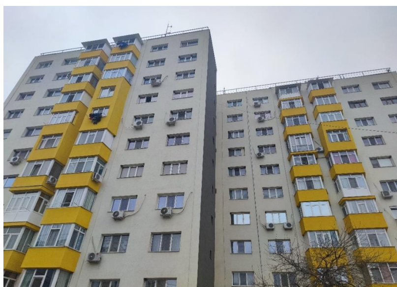
Foto - blocuri reabilitate termic
