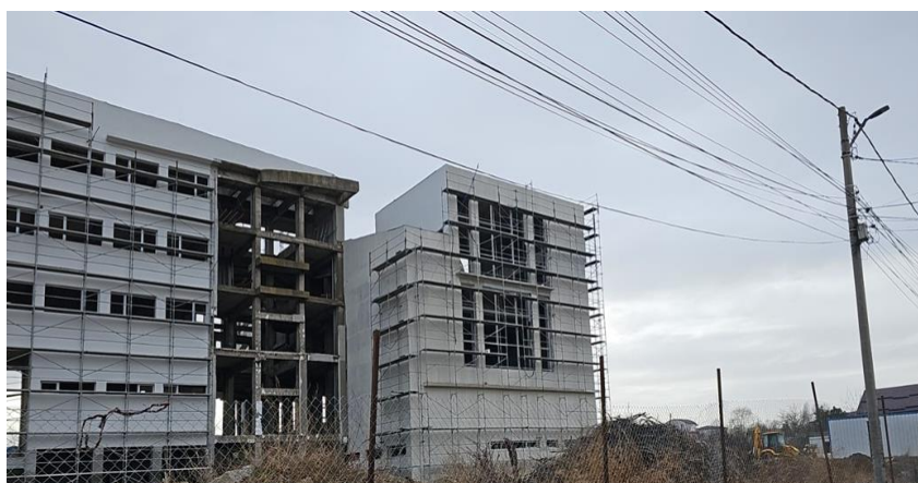
Foto - imagini din timpul execuției lucrărilor la Casa Tineretului
