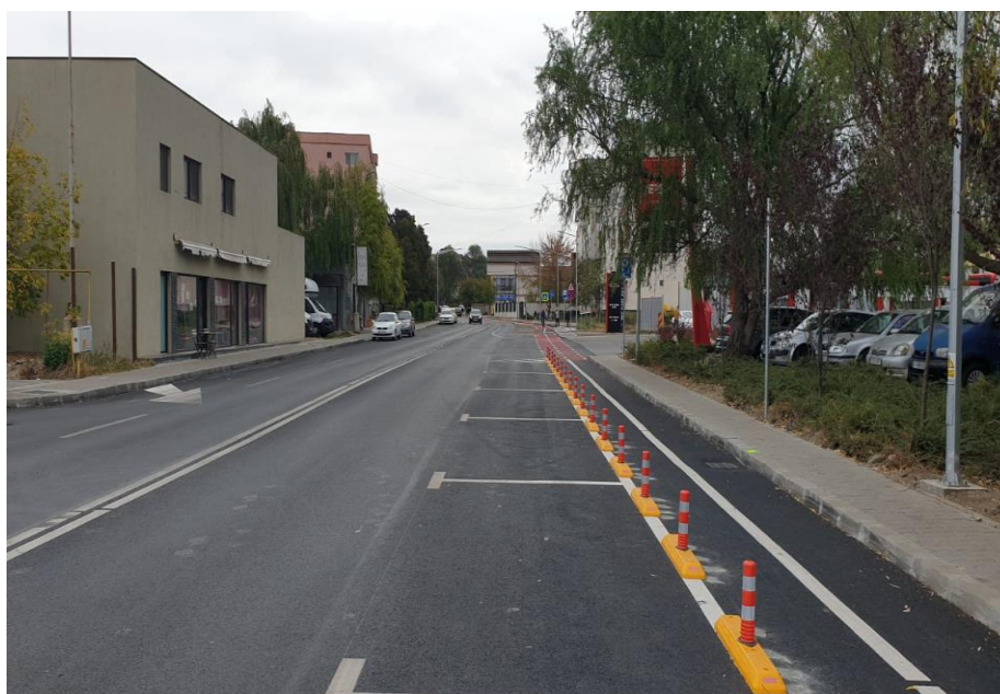
Foto - Str. Miron Nicolescu, reabilitată/modernizată prin proiect
