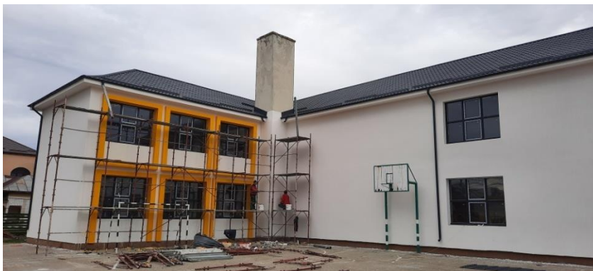
Foto– imagini din timpul execuției lucrărilor
