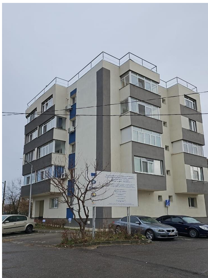
Foto- blocuri reabilitate termic
