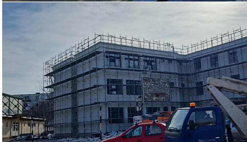
Foto– imagini din timpul execuției lucrărilor
