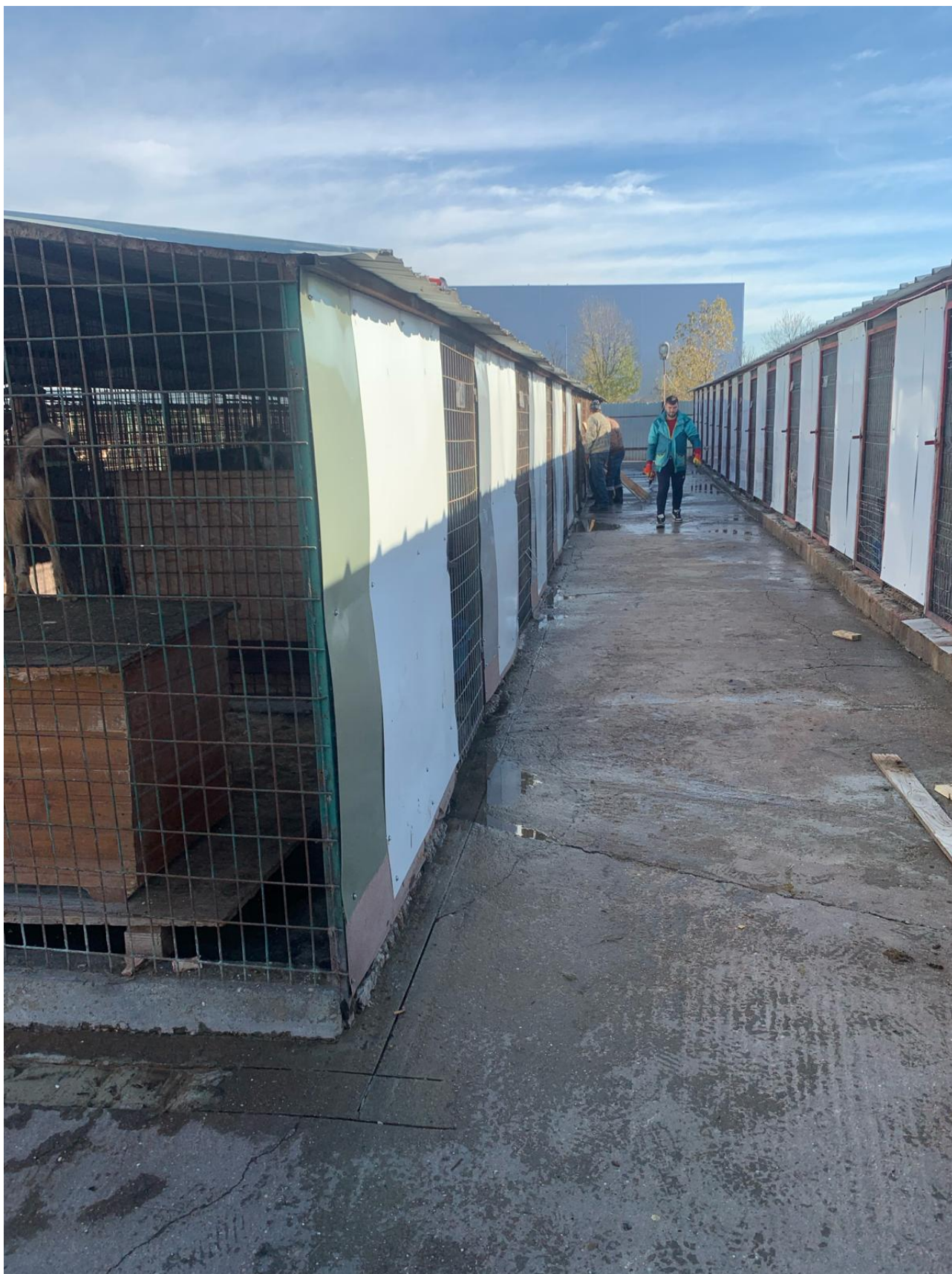
Placare adăpost cu policarbonat
