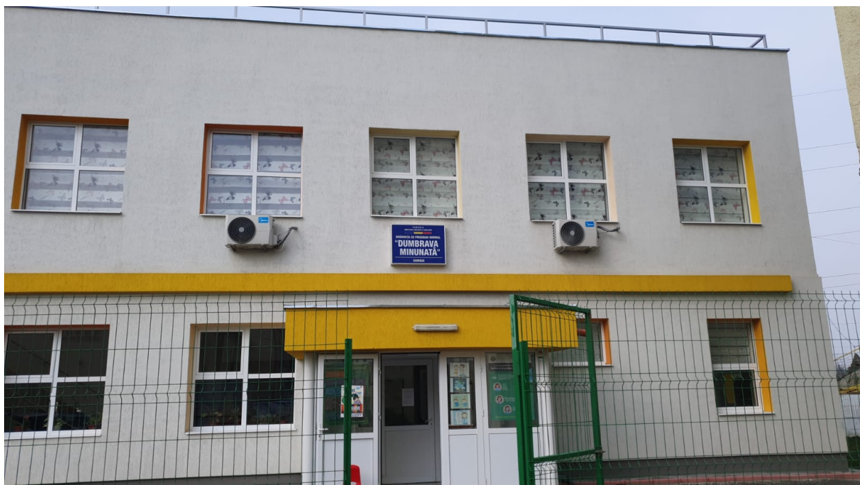
Foto38 - Eficientizare energetică Grădinița cu Program Prolungit Dumbrava Minunată-Corp C2
