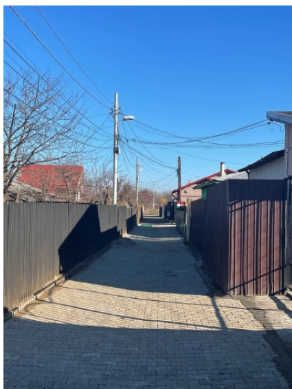
Reabilitare carosabil cu dale behton pe Intrarea Trifoiului
