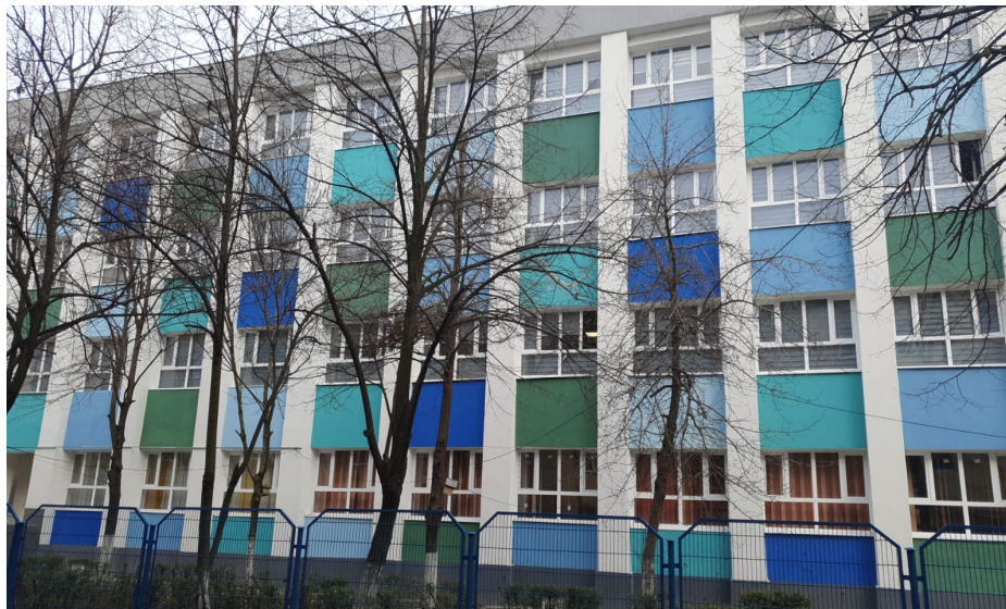
Foto 34 - Eficientizare energetică Școala Gimnazială nr. 5
