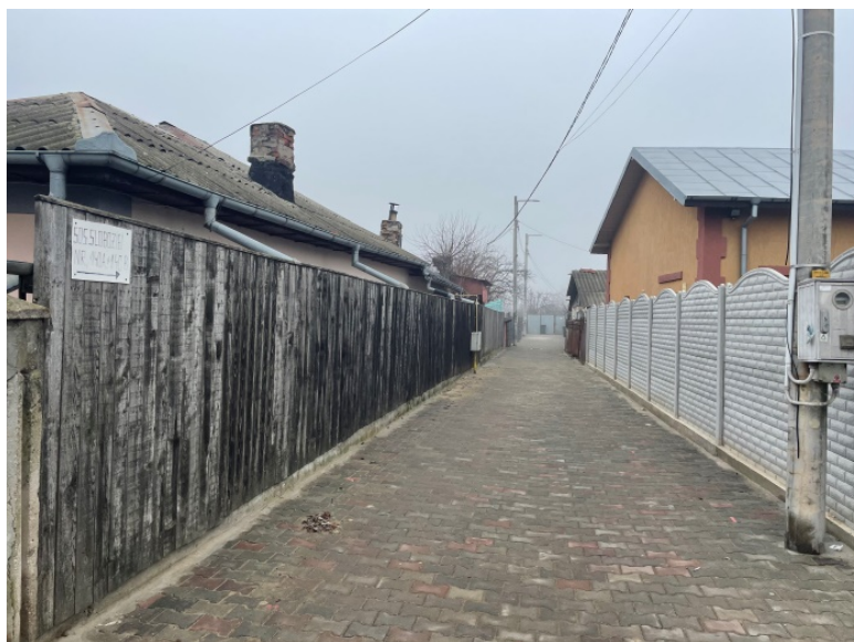
Reabilitare carosabil cu dale behton pe șos.Slobozia nr.140A-140B
