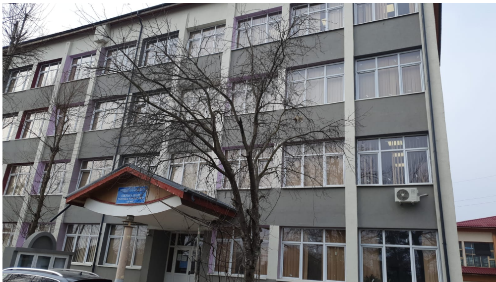
Foto32 - Eficientizare energetică Colegiul Tehnic Viceamiral Ioan Balanescu - Corp C1
