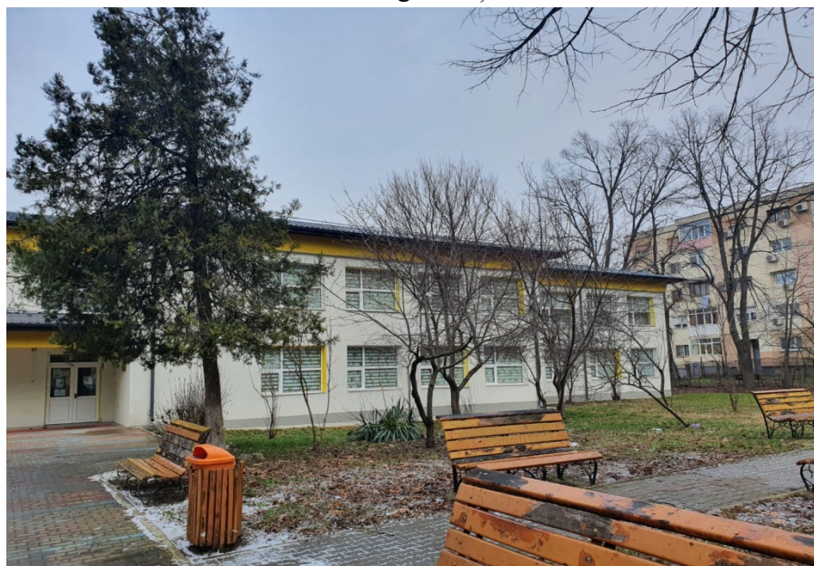
Foto 35 - Eficientizare energetică Grădinița cu Program Normal nr. 9
