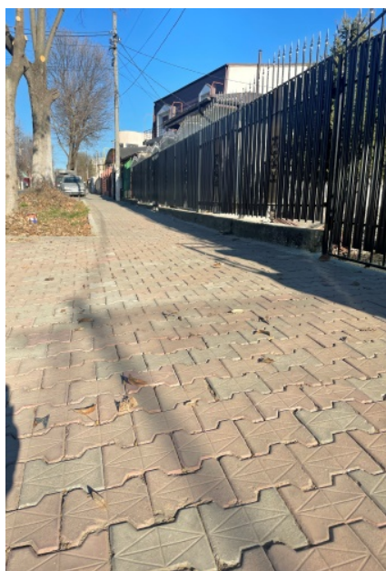
Reabilitare trotuar din dale behton, unde este necesar, pe str. 1 Dec 1918
