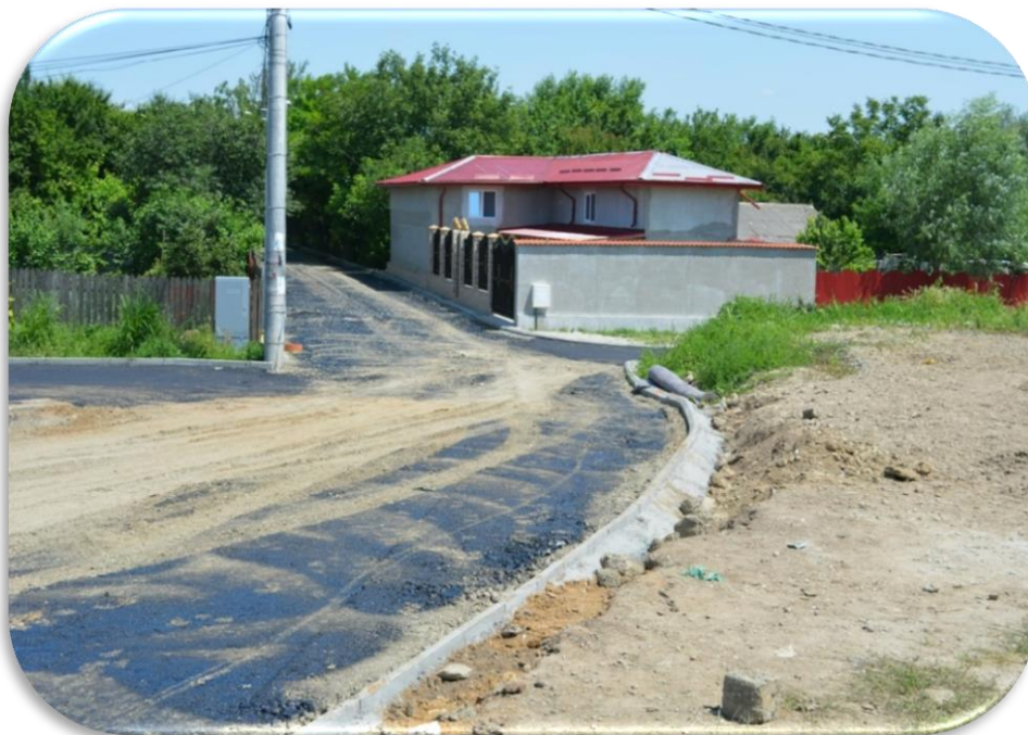
Imagine nr. 10 – Lucrări de asfaltare, drumuri din Municipiul Giurgiu
