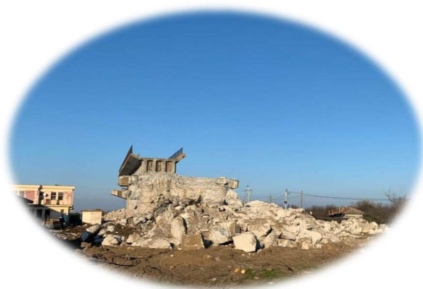
Imagine nr. 6 – Vechiul viaductului pe malul spre Grădiștea distrus Sursă: https://realitateadegiurgiu.net/se-lucreaza-la-refacerea-legaturii-feroviare-bucuresti-ilfov-giurgiu/
