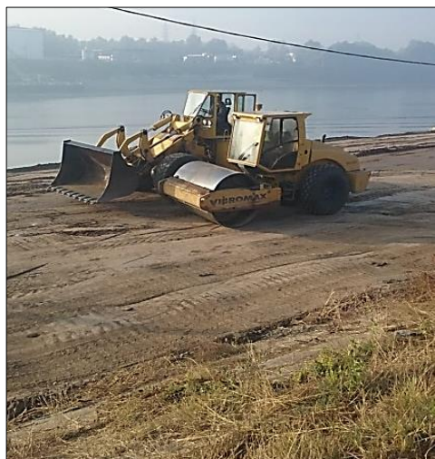
Foto 11 - Începutul lucrărilor a unui sector din malul Canalului Sfântul Gheorghe
