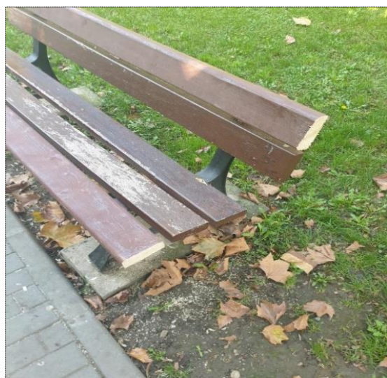
Foto 40 - Reparare mobilier stradal
