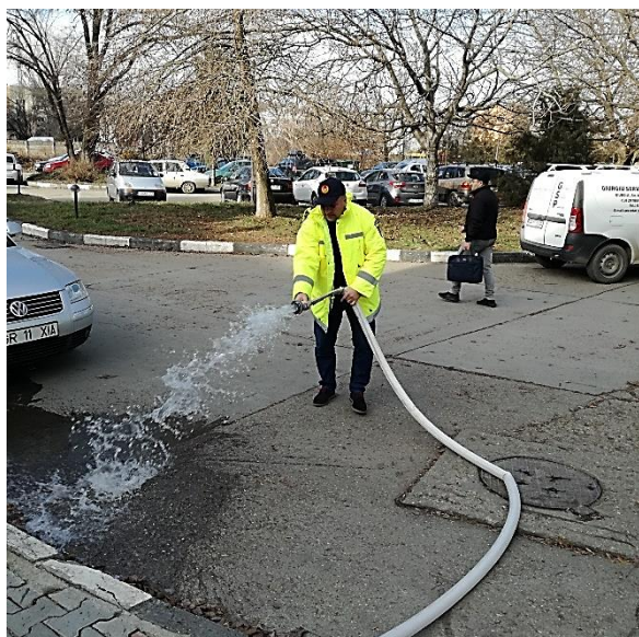
Foto 72 - Evacuare apă pluvială din subsolul clădirii
