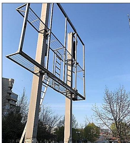
Foto 92 - confecționare și montare panouri led
