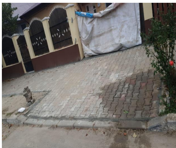
Foto 105 -reabilitare trotuare din dale de behaton și realizare acces auto
