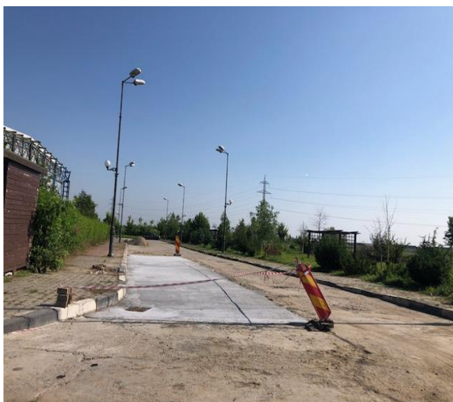
Foto 103 -Reabilitare carosabil prin betonare
