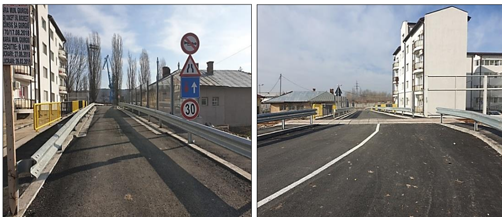
Foto 9- Drum de acces și trecere la nivel cu calea ferată către portul trimodal
