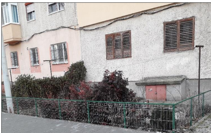
Foto 91 - montare panouri de gard
