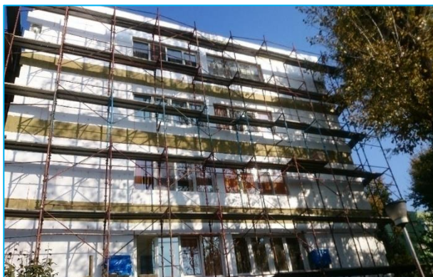
Foto 29-execuția lucrărilor de reabilitare termică a blocurilor de locuințe
