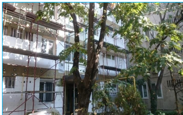
Foto 29-execuția lucrărilor de reabilitare termică a blocurilor de locuințe
