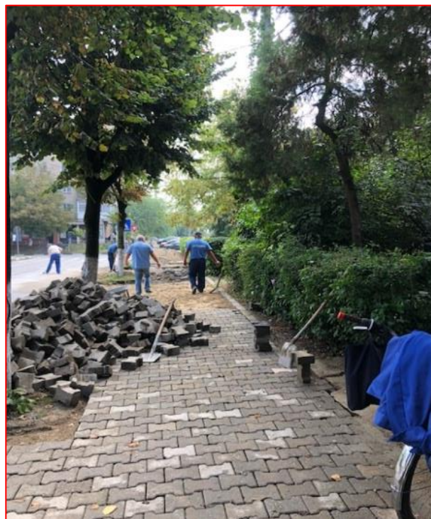
Foto 136 - Reabilitarea Strada Tineretului
