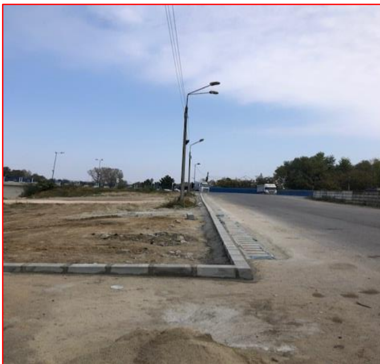
Foto 128- Reabilitare zona adiacenta "Construcție Hidrotehnică" șos. Portului prin montare borduri mari, rigola, geiger cu sistem de scurgere si cămin vizitare
