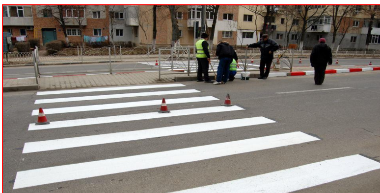
Foto 124 - Marcaj transversal pentru pietoni
