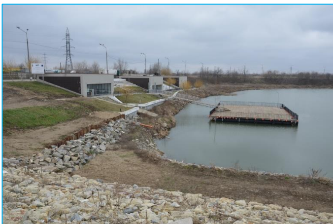
Foto 5 - Consolidarea malului stâng al canalului Cama, adiacent construcție hidrotehnică
