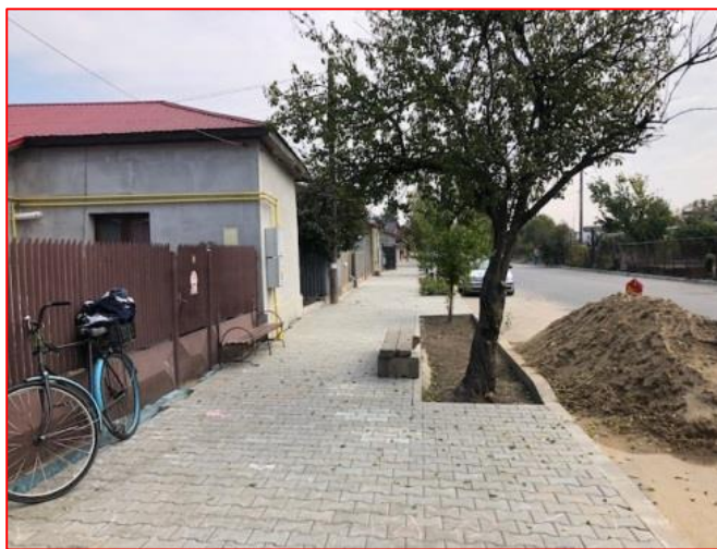
Foto 132 - Reabilitarea trotuar strada Digului
