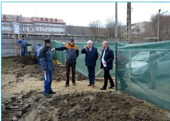
Foto 41 - Demararea lucrărilor la blocurile ANL pentru specialiștii în sănătate
