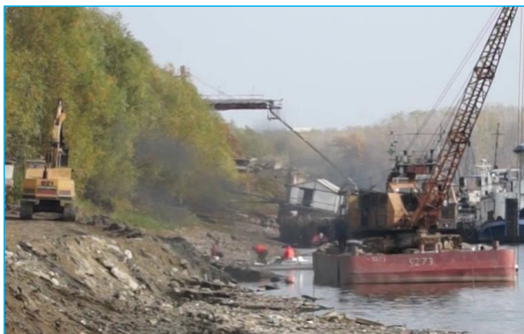
Foto 35 - Începutul lucrărilor de amenajare a unui sector din malul Canalului Sf. Gheorghe
