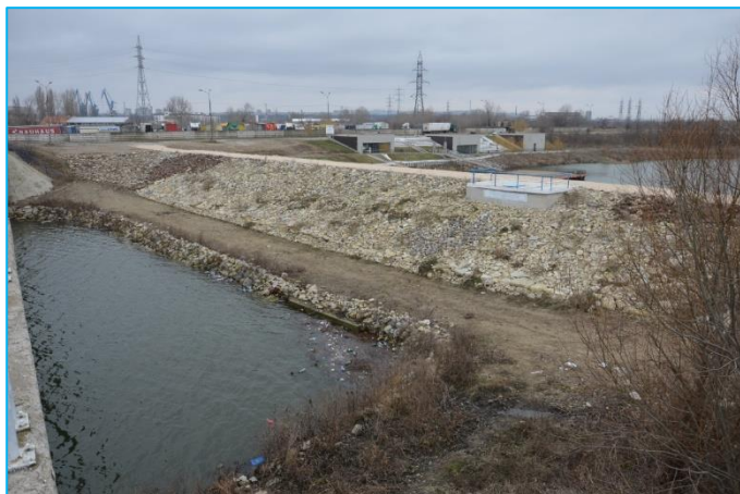
Foto 4 -Construcție hidrotehnică – regularizare canal Cama
