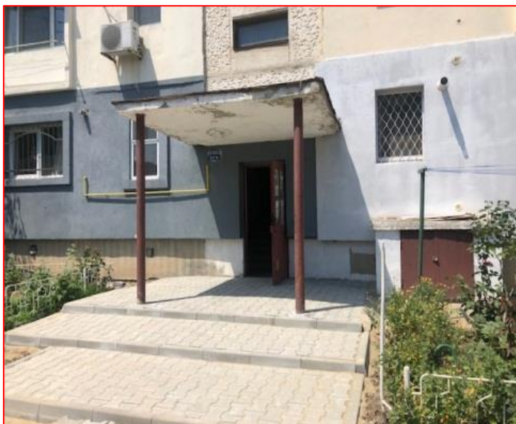
Foto 133 - Reabilitare trotuar intrări scări de bloc - cartier Clopotarii
