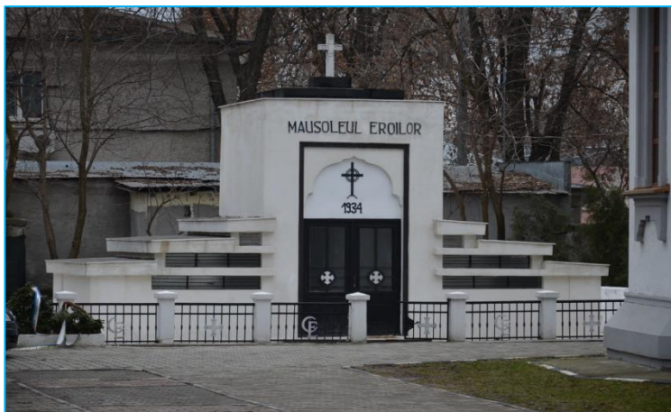
Foto 6 - Reparație mausoleul Eroilor
