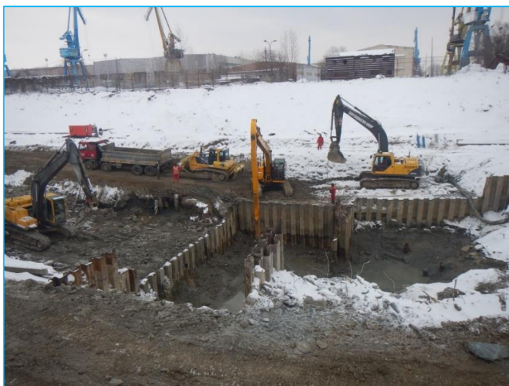
Foto 30 - demolare fundații ferry-boat
