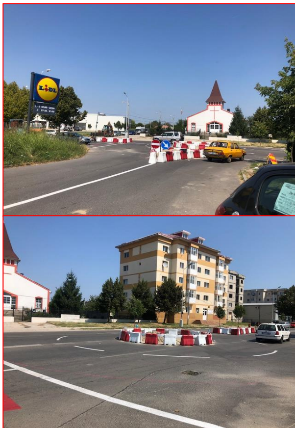
Foto 130 - Amenajare sens giratoriu intersecție str. Cărmidarii Vechi – Supeco - Biserica Baptistă
