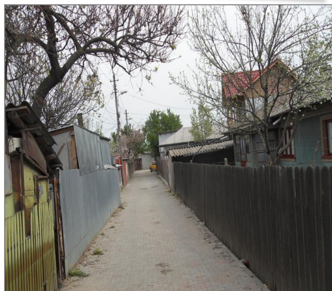
Figură 126 - Reabilitare strazi cu dale behaton reutilizate
