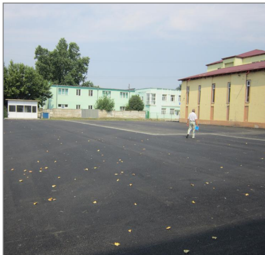
Foto 124 - Reabilitare carosabil prin betonare
