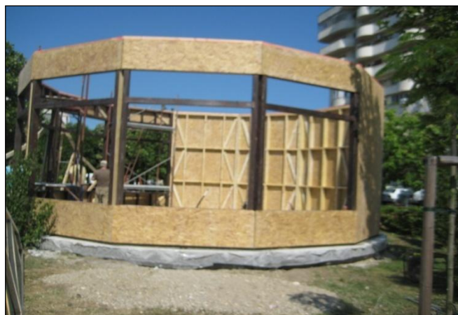
Foto 22 - CNIPT - în construcție
