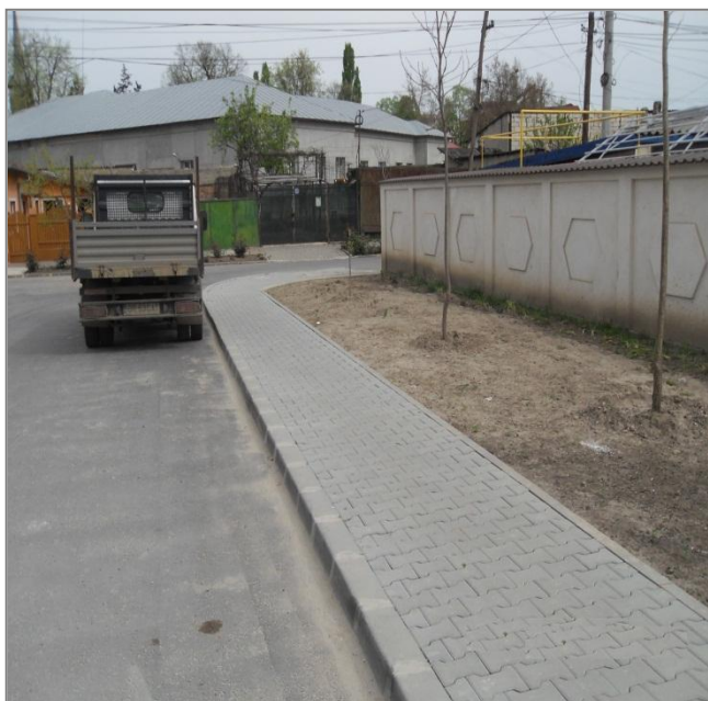
Foto 127 - Amenajare trotuare cu borduri si dale behaton
