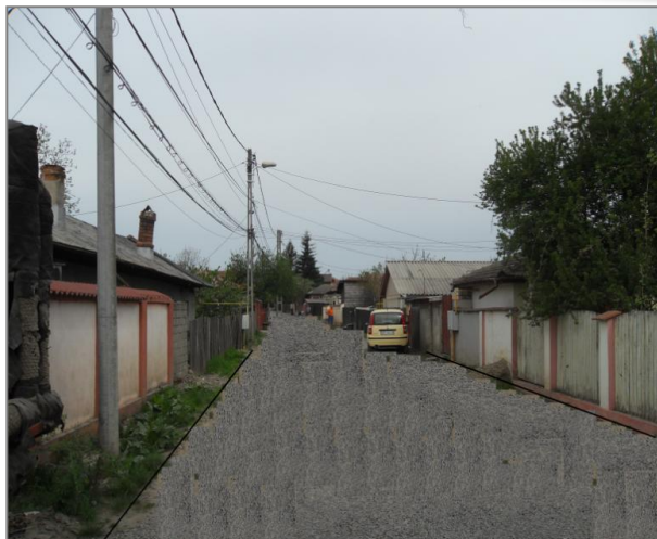
Foto 125 - Reabilitare străzi de pământ prin aşternere piatră spartă
