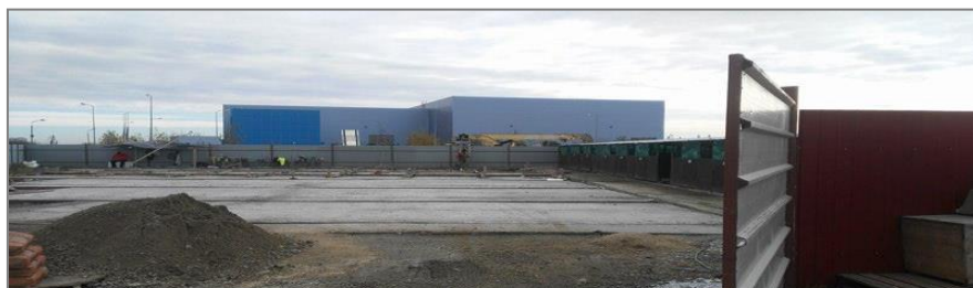
Figură 120 - extindere adăpost pentru câinii fără stăpân
