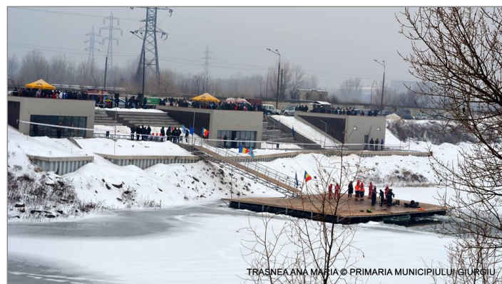
Foto 29 - Agrement canal Cama - lucrare finalizată
