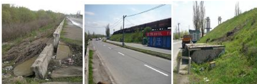
Foto 88 - Situația existentă zona Vamă - Podul Prieteniei
